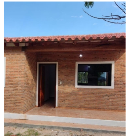
Hausbau für den Vorarbeiter in Cerro Azul
