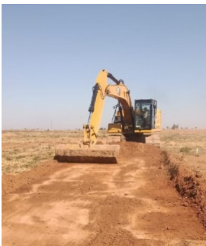
Nivellierung der Flächen
